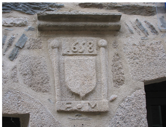
Détail de la Maison de la Vigerie
